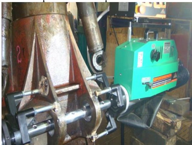
Ремонт грейферного захвата
