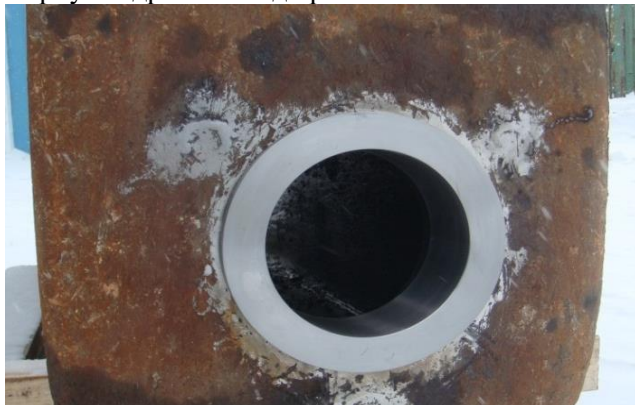
Корпус гидромолота после ремонта
