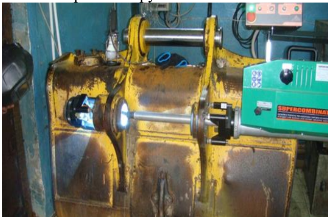
Ремонт ковша экскаватора
