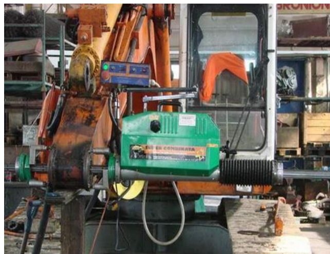
Ремонт стрелы экскаватора
