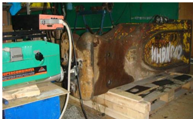
Ремонт корпуса гидромолота
